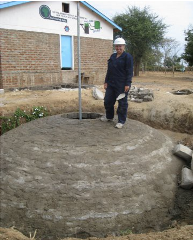
Illustrasjon 4: The biogas digester is almost complete
