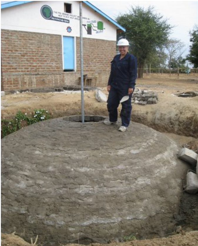
Illustrasjon 4: The biogas digester is almost complete
